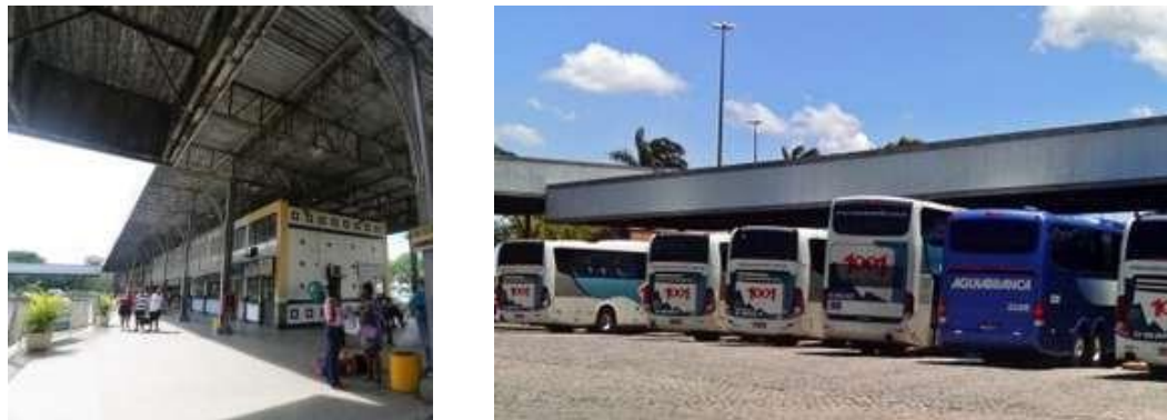
Figura 18: A estrutura do Terminal a Shopping Estrada.
