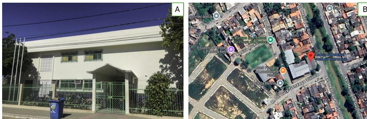
Figura 1 Sede do Clube de Ciências: A) Fachada da Escola Municipal José do Patrocínio (EMJP); B) Localização espacial da EMJP (Fonte: Google Maps, 2024).
