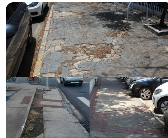
Vistorias em calçadas e estacionamento. Fonte: Couto, 2024
