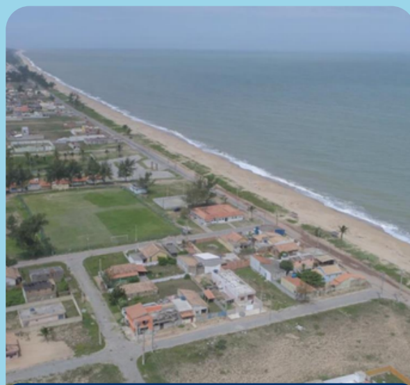
Fotografia representativa da Subunidade Geoambiental Cordão Arenoso com ocupação consolidada. Fonte: Bulhões, 2020
