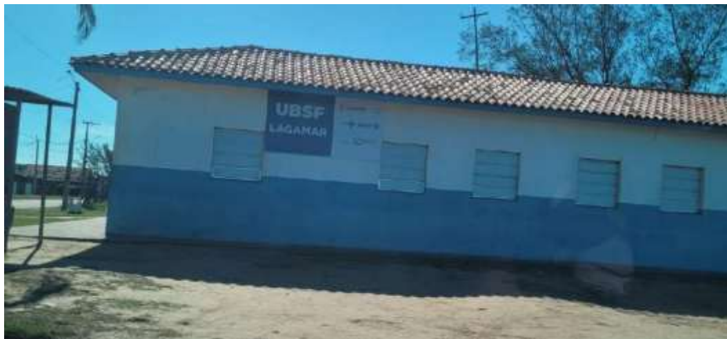
Figura 16 - Edificação de uso público e ocupação permanente dentro da frente de praia e da faixa de erosão intensa ao longo da orla marítima de Campos dos Goytacazes. Foto da Autora.
