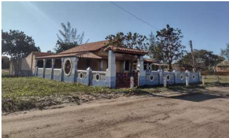
Figura 16 - Edificação de uso residencial e ocupação de veraneio dentro da frente de praia e da faixa de erosão severa ao longo da orla marítima de Campos dos Goytacazes. Foto da Autora.
