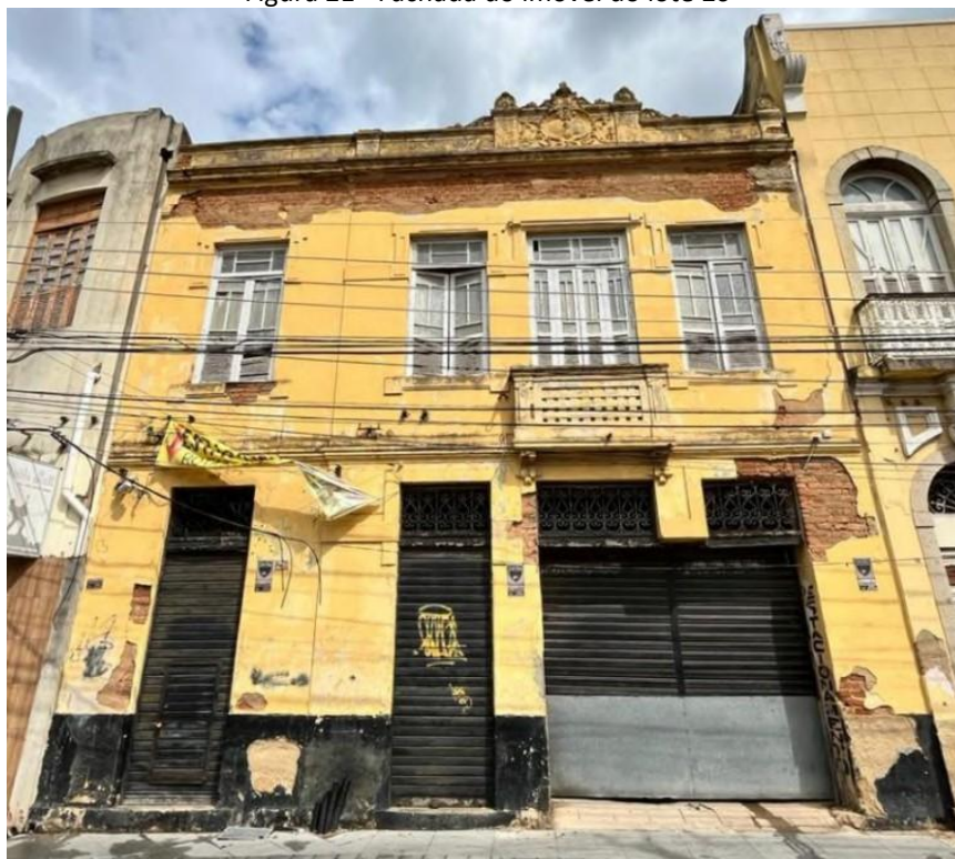
Figura 21 - Fachada do imóvel do lote 26
