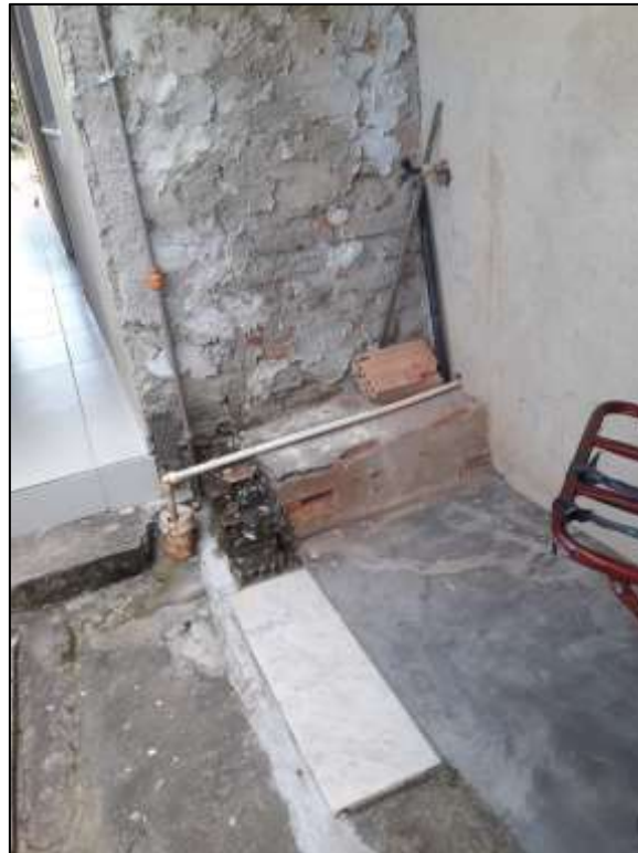
Figura 4. Poço de residência localizada no Parque Aurora.
