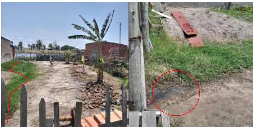
Figura 23. Esgotamento sanitário de uma residência para dentro da lagoa do Lagamar.
