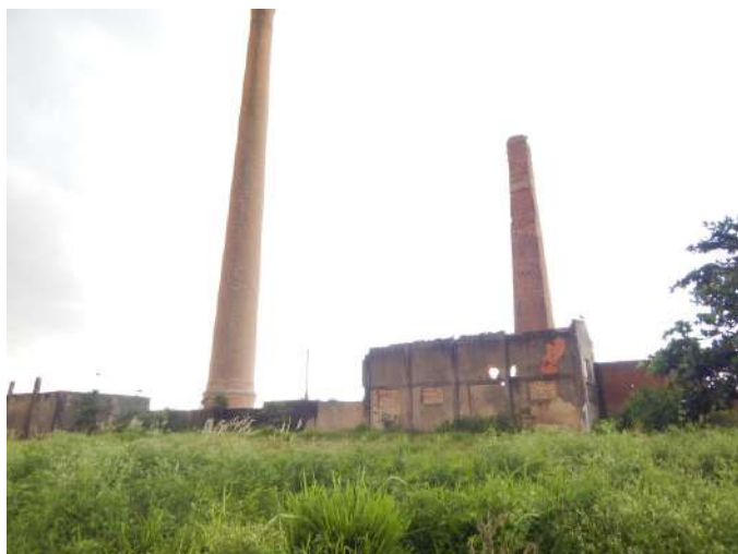
Muro que cerca o terreno e as duas chaminés. Dez. 2019. Fonte: Arquivo pessoal.
