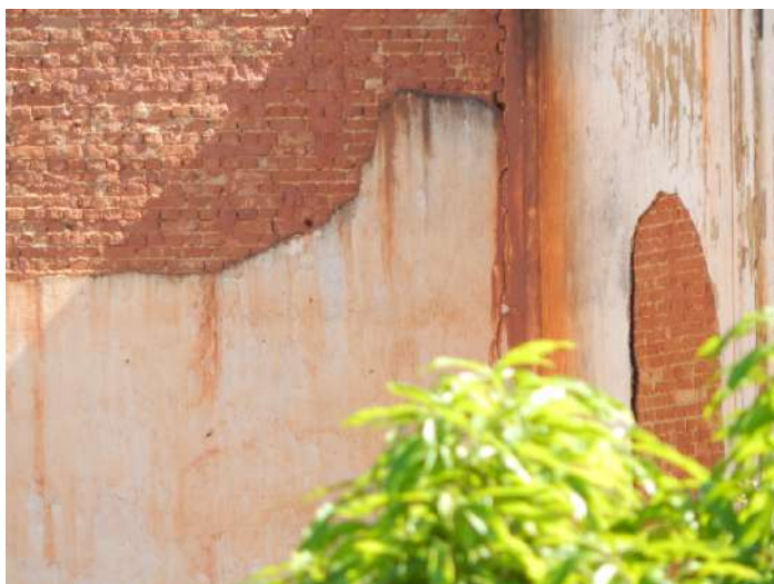
Paredes galpão 2. Fonte: Arquivo pessoal, 2019.
