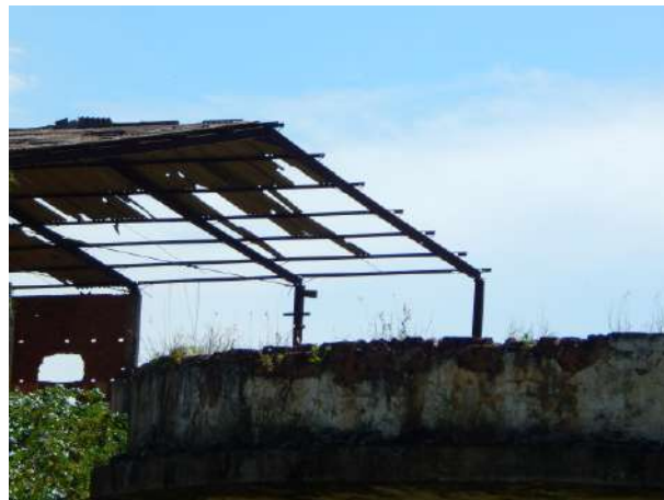
Cobertura galpão 1. Fonte: Arquivo pessoal, 2019
