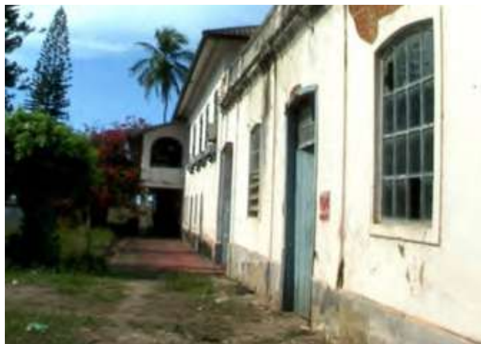
Casarão com esquadrias de ferro e vidro e madeira. Fonte: Gantos, s/d.
