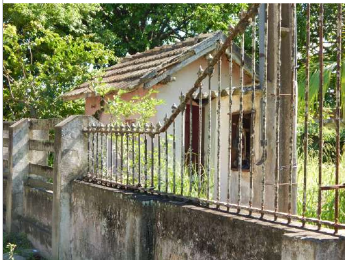
Gradil e muro da suposta residência. Fonte: Arquivo pessoal, 2019.
