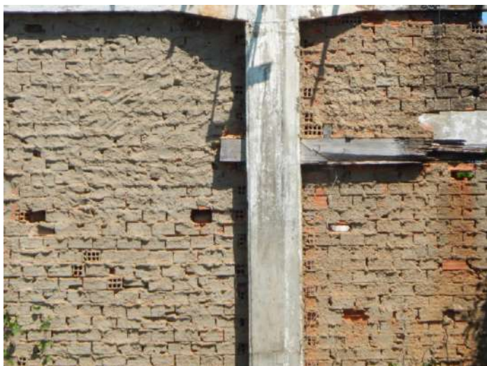
Parede lateral esquerda com algumas aberturas. Dez. 2019. Fonte: Arquivo pessoal.
