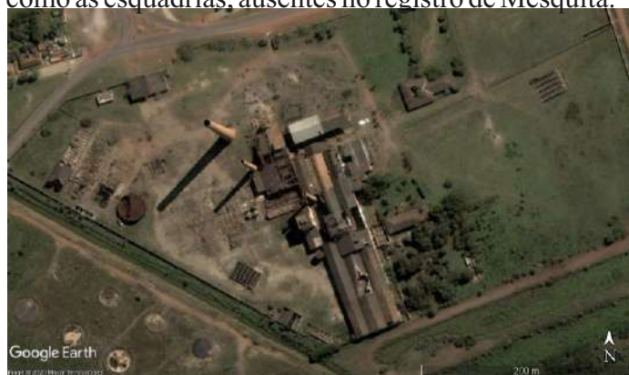
Degradação da usina em 2004. Telhado antigo da casa ao lado da usina. Fonte: Google Earth
