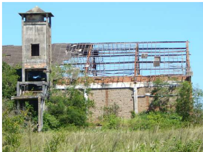
Parede lateral esquerda. Dez. 2019 Fonte: Arquivo Pessoal
