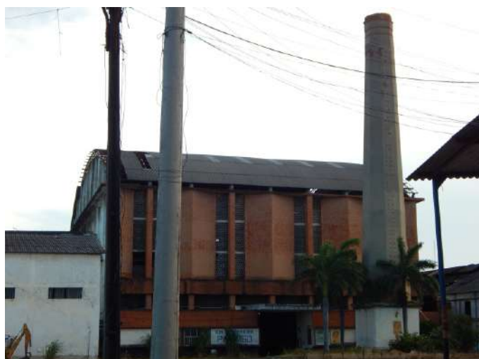
Chaminé e galpão com características brutalistas. Dez. 2019. Fonte: Arquivo Pessoal
