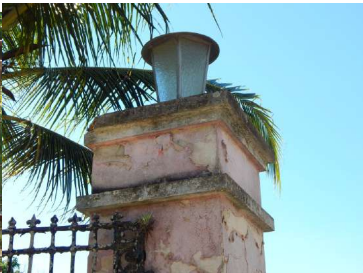
Coluna e lanterna da suporta residência. Fonte: Arquivo pessoal, 2019
