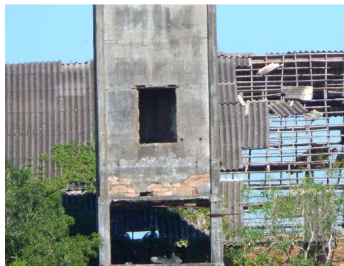
Verga com estrutura aparente. Dez. 2019. Fonte: Arquivo pessoal.
