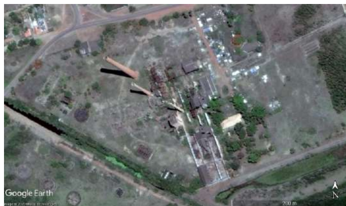
Degradação da usina em 2014. Fonte: Google Earth
