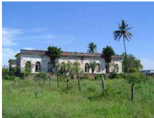
Ruínas do prédio da administração. Dez. 2004. Fonte: Fichas de inventário, 2004.
