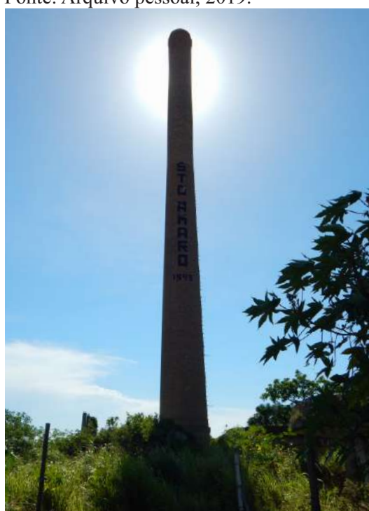
Chaminé Usina Santo Amaro Fonte: Arquivo pessoal, 2019.
