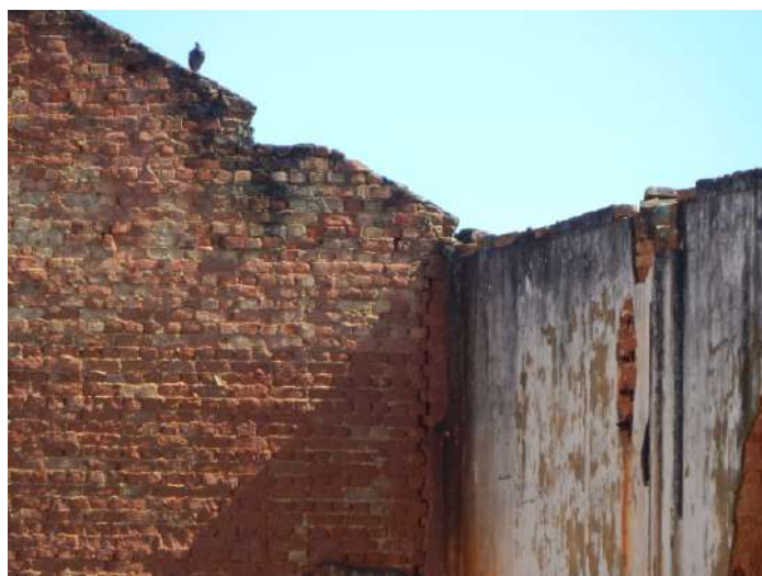
Parede galpão 2. Fonte: Arquivo pessoal, 2019
