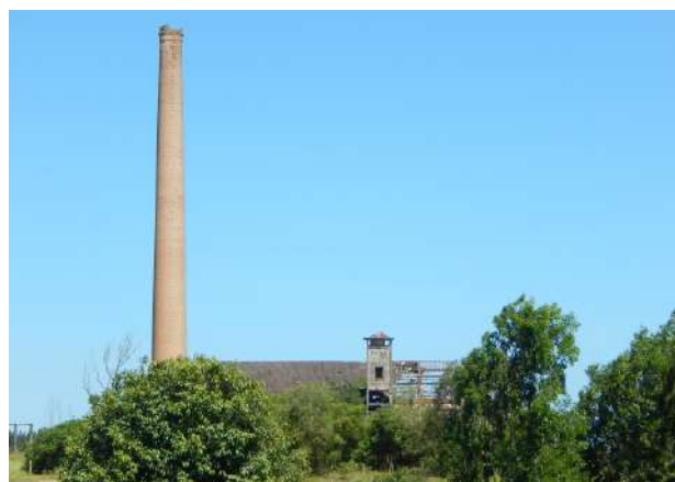
Vista lateral da usina. Dez. 2019.
