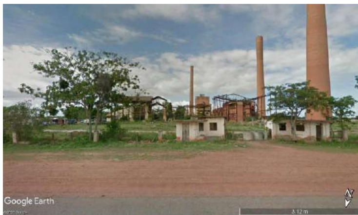
Estruturas metálicas existentes próximo à rodovia. Abr. 2015. Fonte: Google Earth
