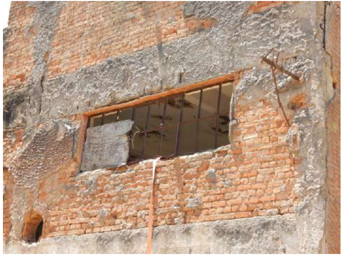
Vigas aparentes na estrutura de concreto e vedação de tijolo maciço. Fonte: Arquivo pessoal. Dez de 2019.
