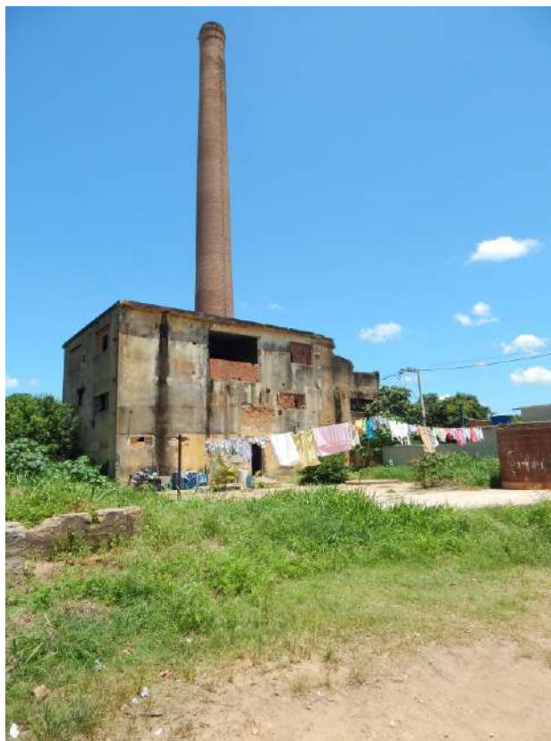
Destilaria Central, construída em cima da Usina N. S. das Dores. Dez. 2019
