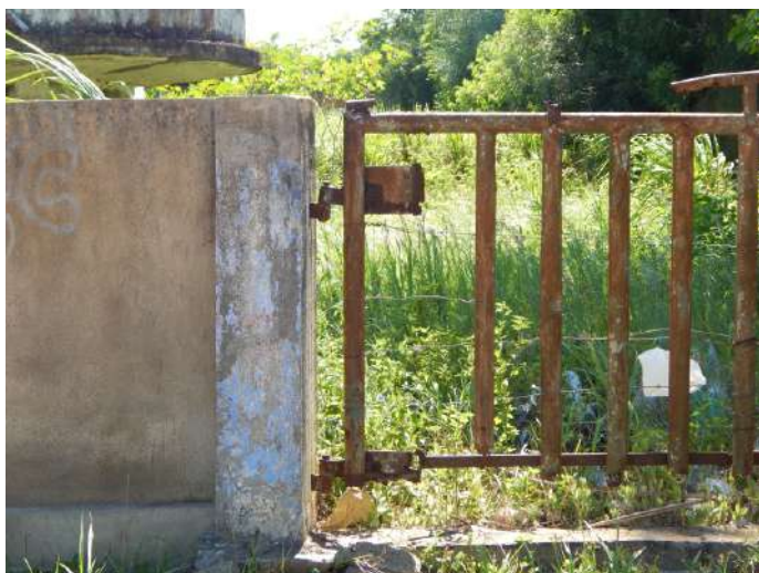
Muro e portão de acesso à usina. Fonte: Arquivo pessoal, 2019
