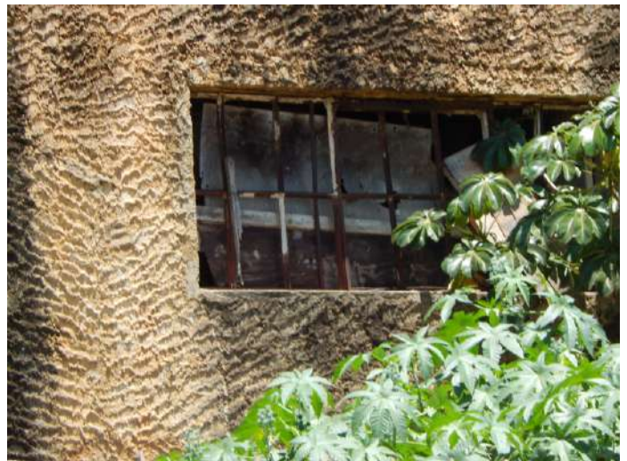
Grade de ferro em algumas aberturas de janela. Fonte: Arquivo pessoal. Dez de 2019.
