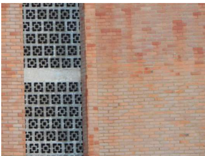
Detalhe do galpão. Dez. 2019. Fonte: Arquivo Pessoal
