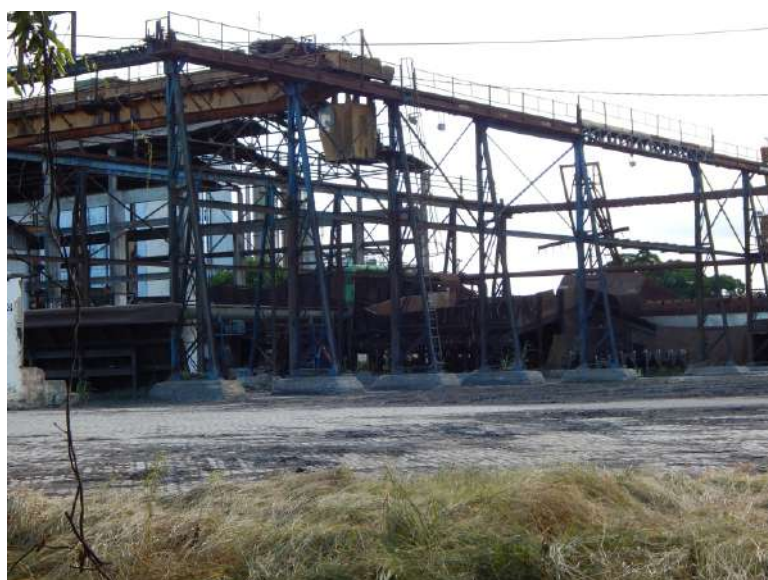
Estrutura metálica aparentemente em bom estado. Dez. 2019. Fonte: Arquivo Pessoal.
