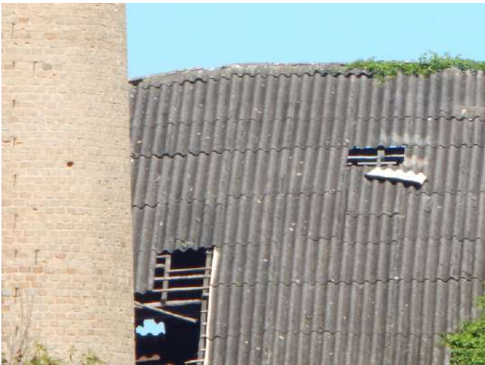
Cobertura do galpão maior Dez. 2019 Fonte: Arquivo Pessoal
