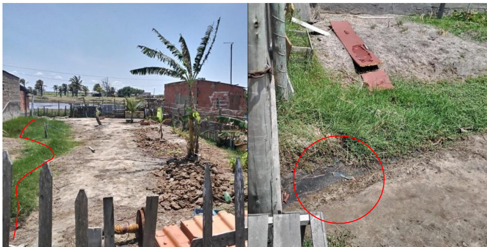
Figura 4. Esgotamento sanitário de uma residência para dentro da lagoa do Lagamar.
